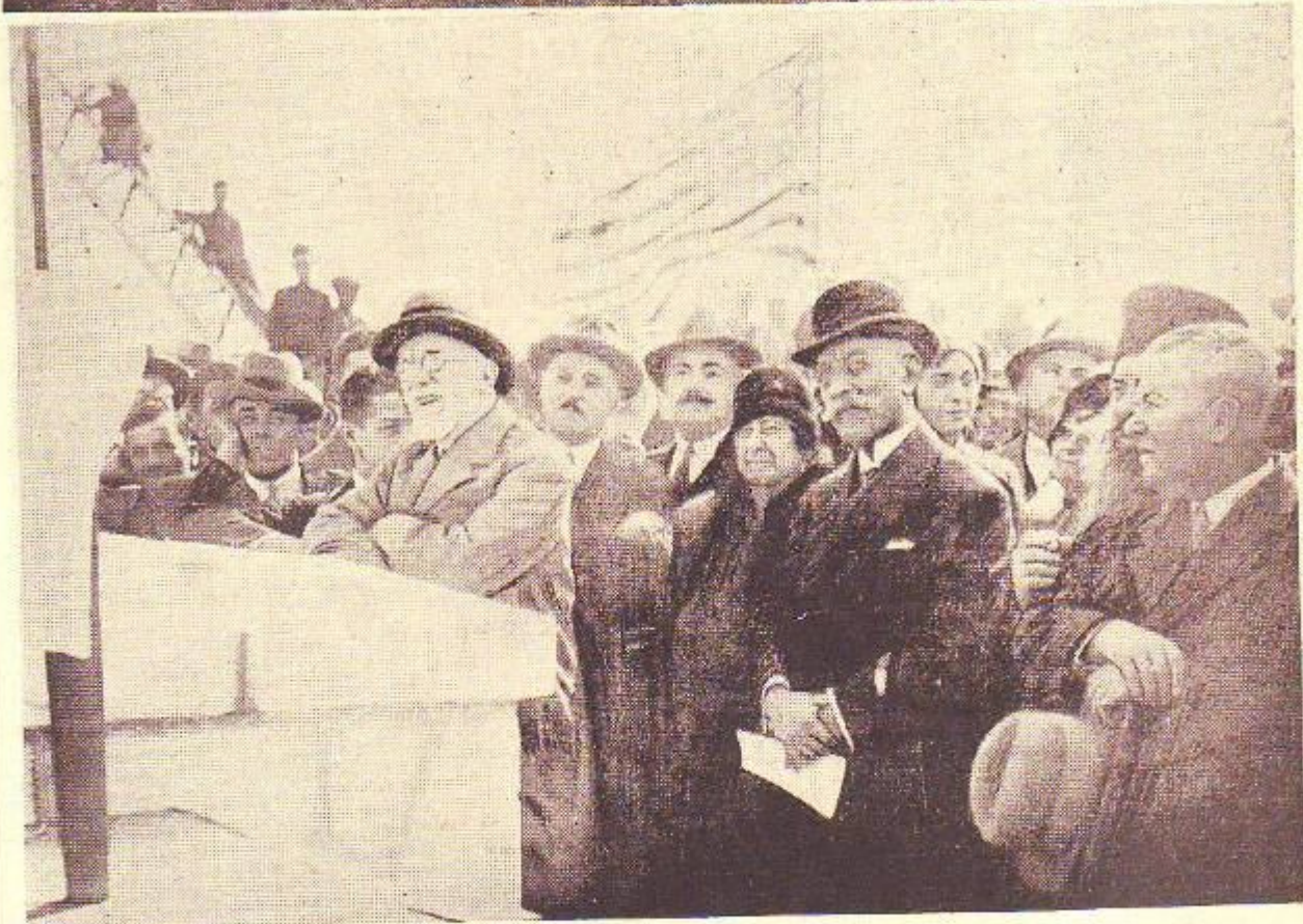
*Ανω: Άποψη του φράγματος που αγέρθη εις την είσοδον της βαθείας σάραγγος του Μαραθώνος και εις τὸ πηγεῖον ὅπου συμβάλλουσιν οἱ χείμαρροι Χάραβρος καὶ Βυονάβος καὶ σχηματίσθη ἡ τεχνητὴ λίμνη τοῦ Μαραθῶνος ἀπὸ τῆν ὅποιαν ὑδρεύονται αἱ Ἀθῆναι. Κάτω (Ἰ. Οκτώβριος 1929): Τὰ ἐγκαίρια τῆς λίμνης τοῦ Μαραθῶνος. Ὁ Ἐλευθέριος Βενιζέλος ὁμιλεῖ ἐξαιρῶν τὴν σημασίαν τοῦ ἐκτελεσθέντος ἔργου. Διασκοίνονται μεταξύ τῶν λοιπῶν παρισταμένων ὁ τότε πρόεδρος τῆς Δημοκρατίας Παῦλος Κουντουσιώτης καὶ πρὸς τὰ δεξιὰ του ἡ κ. Ἐλενα Βενιζέλου.
