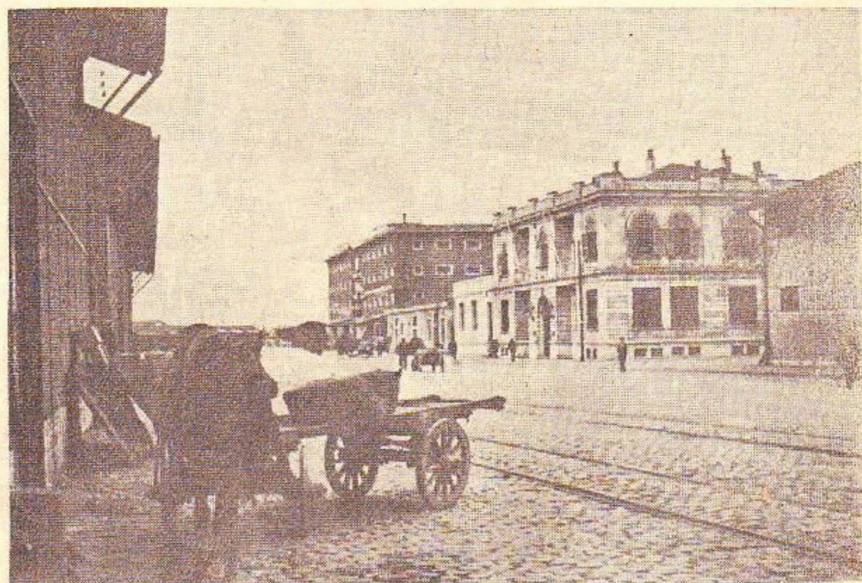
*Ανω : Ἡ παραλιακὴ δόδος καὶ ὁ Λευκὸς Πύργος. Κάτω : Ἡ περιοχὴ τῆς Ἐλευθέρου Ζώνης μετὰ τὰ κτίρια καὶ τὰς ἀποθήκας.
