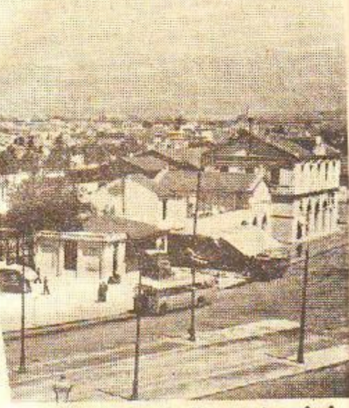
5, με τό κτιριακόν συγκρότημα του σταθμού Σ.Ε.Κ. (δεξιά).
